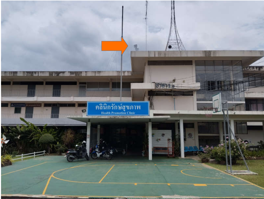
8. การติดตั้งเสากระจายสัญญาณบนอาคารสูง
