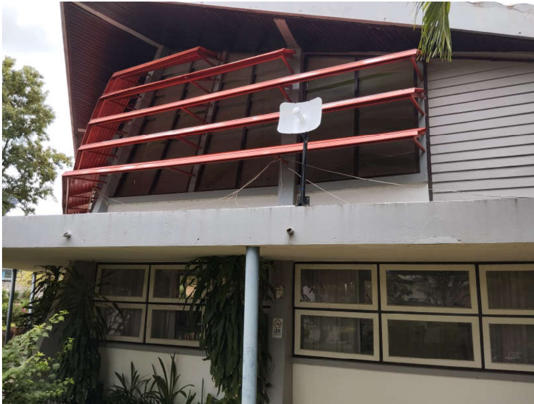
10. ภาพการติดตั้งเสารับส่งสัญญาณบริเวณอาคารเฉลิมราช
