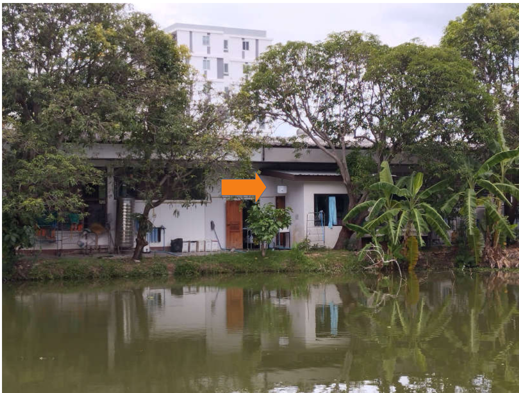
9. ภาพแสดงการติดตั้งเสารับส่งสัญญาณ Wi-Fi ในพื้นที่ไม่สูง
